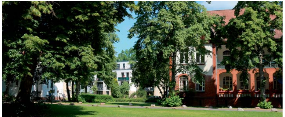
Abb. 5.3/75 Blick auf die neue Wohnbebauung Eichenpark aus dem Stadtpark
