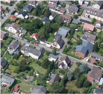
Abb. 5.3/13 Freistehende Einfamilienhäuser im Birkenweg, Krähenwinkel
