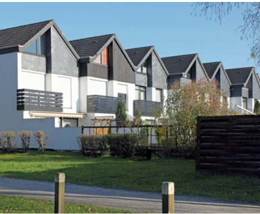
Abb.5.3/41 Reihenhäuser Horner Straße
