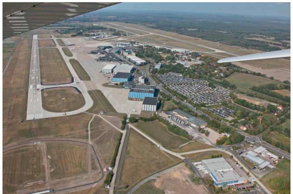
Abb. 5.4/6 Blick von Westen auf die Landebahn und die Airport-City
