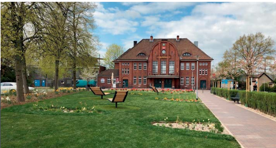
Abb. 5.3/70 Umgestalteter Bahnhofsvorplatz, Pferdemarkt
